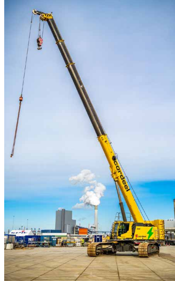
Een van de eerste hybride hijskranen op de markt werd recent ingezet voor een project in Nederland.
